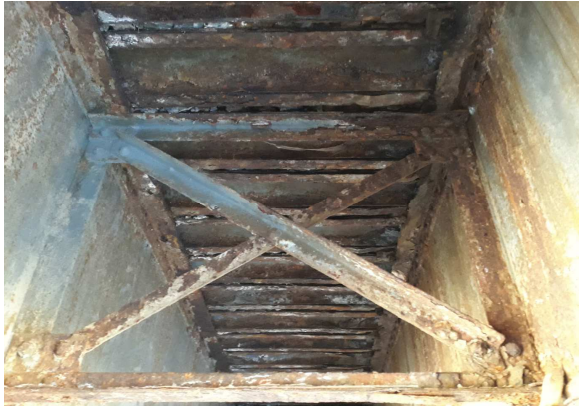
Pohľad medzi hlavné nosníky na priečne stužidlá
