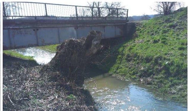
Pohľad na most z ľavého brehu Čaradického potoku ( od železničného mostu)
