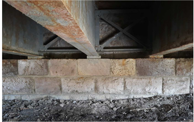
Pohľad na opory a uloženie nosníkov
