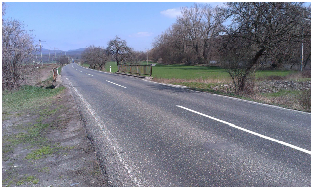
Pohľad na most z južnej strany
