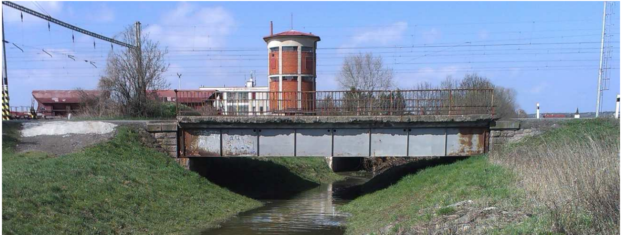
Východný pohľad na most (od Hronu)
