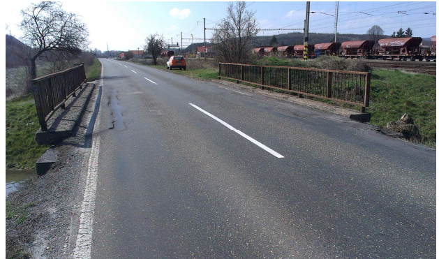
Pohľad na most zo severnej strany
